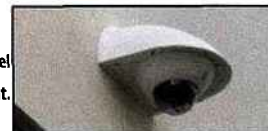
>D14-Support casquette : caméra Mobotix 3 Mégapixel de type dôme montée sur façade de bâtiment.
